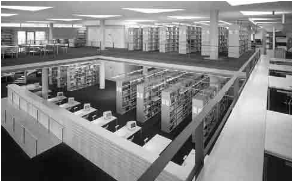
figura 280 Die Deutsche Bibliothek, Francoforte. Sistemi di scaffalature a file parallele con illuminazione fluorescente dei corridoi installata su struttura metallica fissata agli scaffali stessi.
